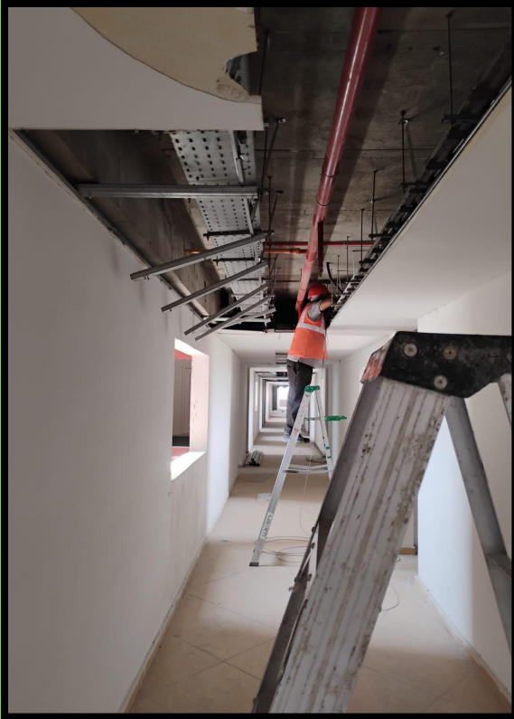
1620 & 1628 Flats incoming wiring WIP
